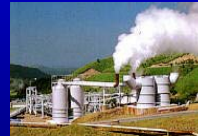
八丁原地熱発電所
