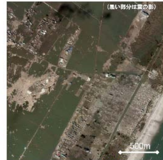
被災後(平成23年3月12日撮影)
