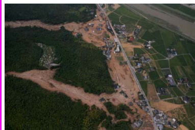
防府市 まな 真尾(2名死亡) 土石流により集落が被災
