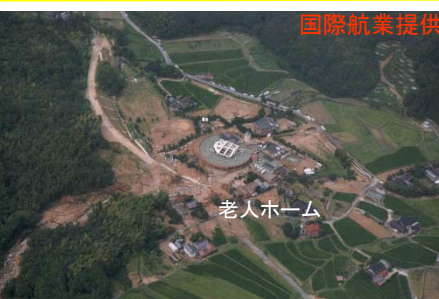
防府市 まな 真尾(7名死亡) 土石流により老人ホームが被災
