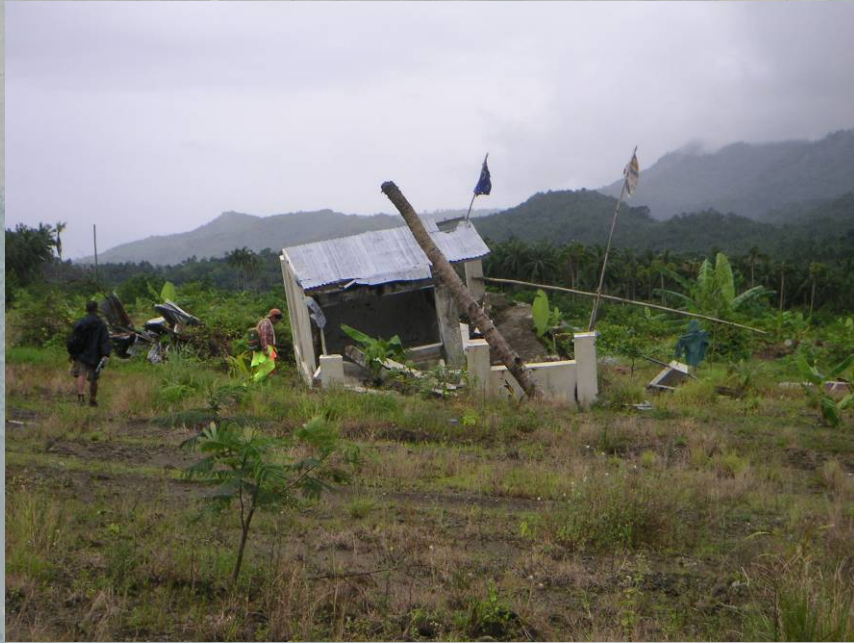
泥流で潰れた家
